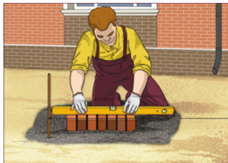
Бордюр формируется укладкой клинкера на ребро. Возможны и другие варианты: установка клинкерных кирпичей на тычок (вертикально) или использование специальных бордюрных камней.
