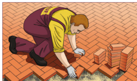
Мощение поверхности с формированием узора «елочка».
