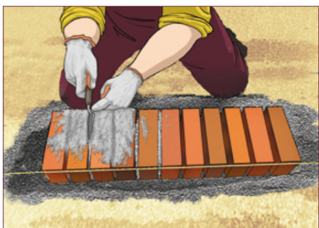
Швы заполняются слоем раствора. Свежий раствор удаляется с поверхности камней мокрой щеткой.
