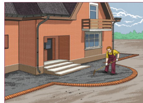
Щебень предварительно выравнивается с использованием подручного инструмента (лопаты, граблей, правила).
