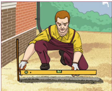
Слой раствора под бордюр раскладывается по разметке с учетом уклона 1,5-2%.
