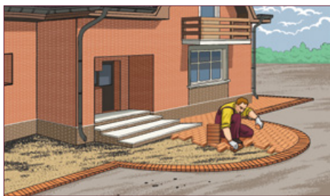
Укладка очередных рядов клинкерной брусчатки.
